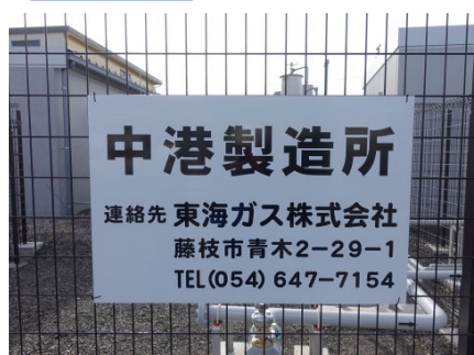
温泉メタン都市ガス化施設
