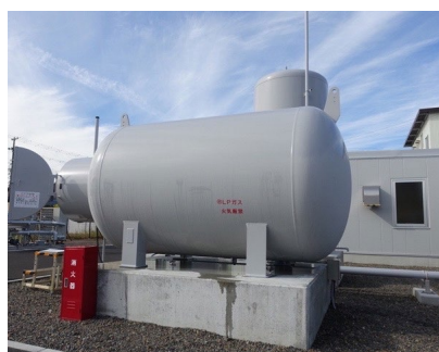
増熱用LPガス貯蔵タンク
